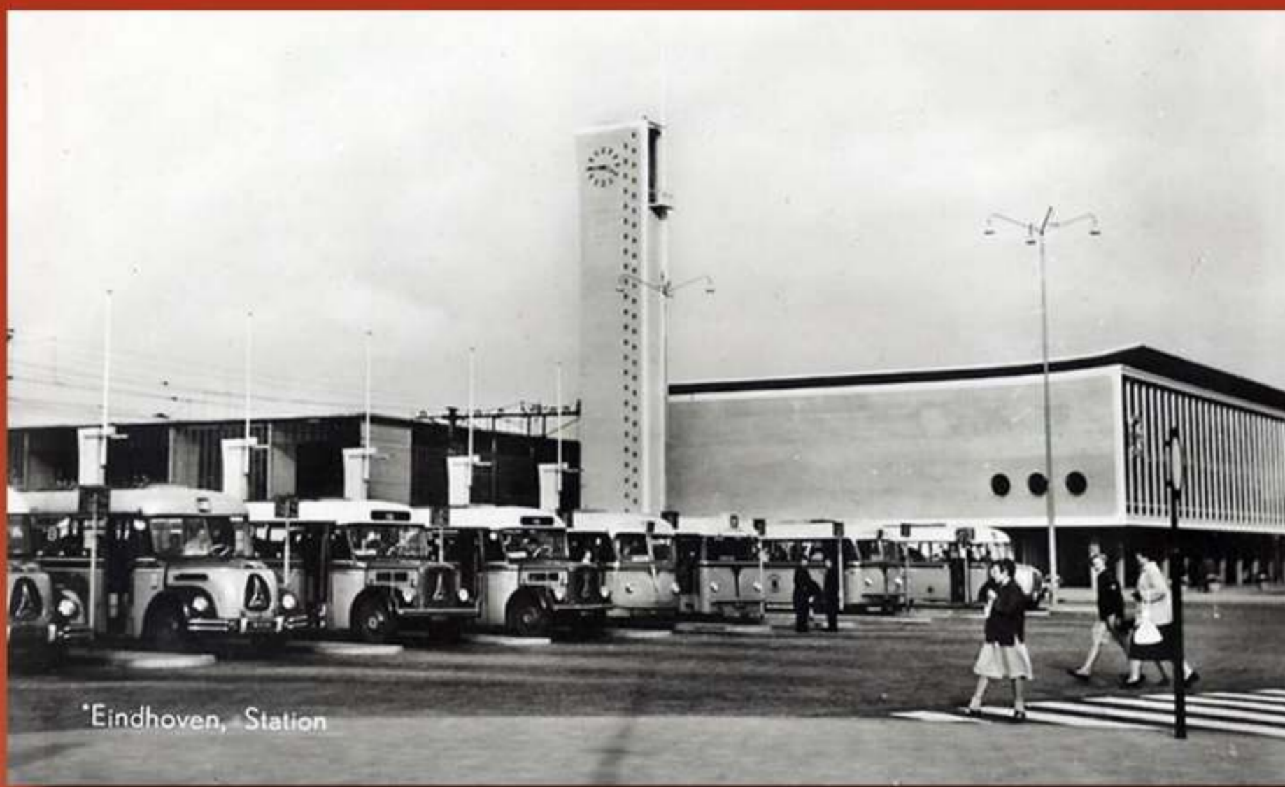
Busstation aan het 18 septemberplein
