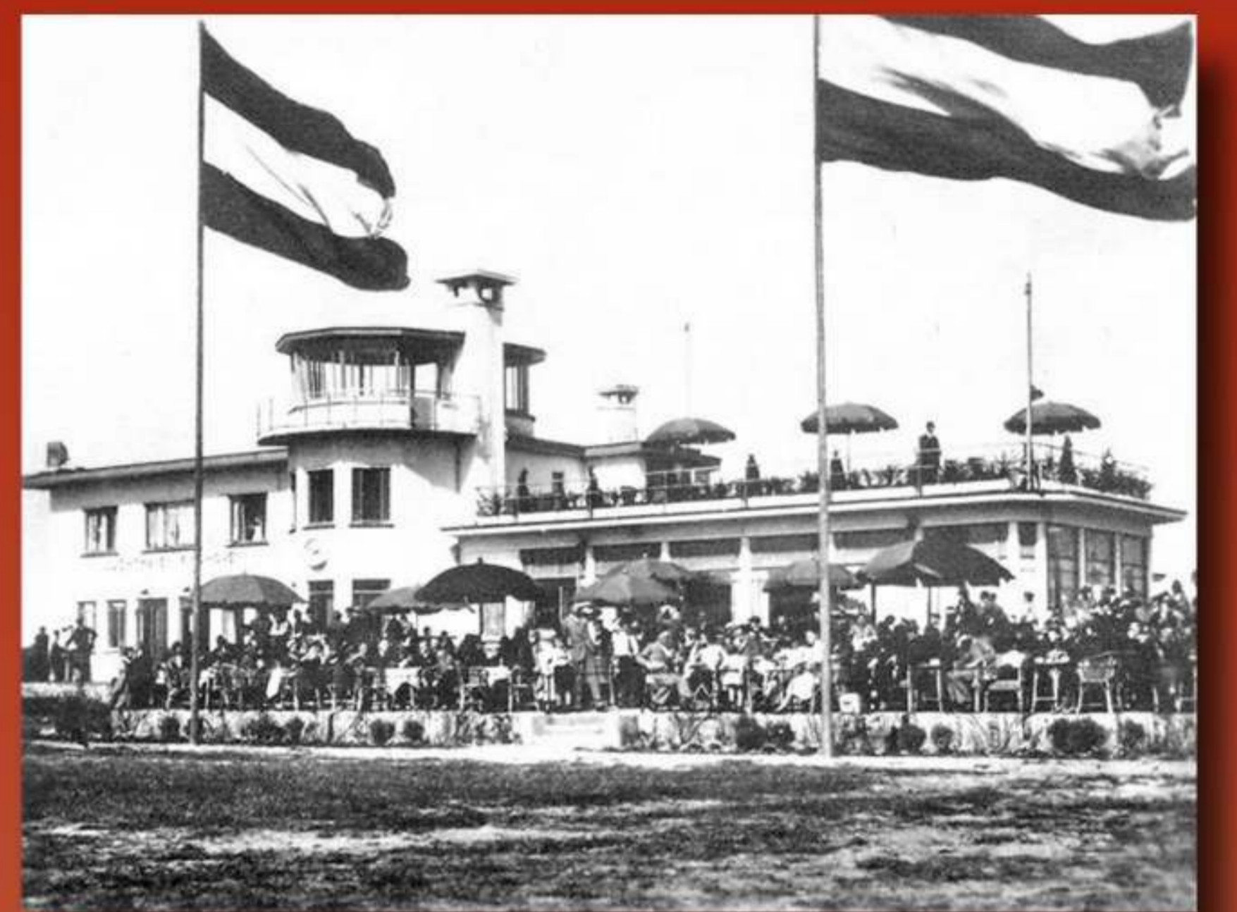
Opening verkeerstorengebouw Welschap 1935
